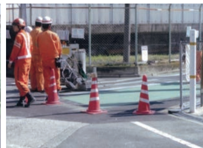
<通学路安全カラー舗装工事>
