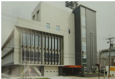
＜新消防庁舎 外観＞
