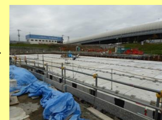
<高宮ポンプ場整備状況>
