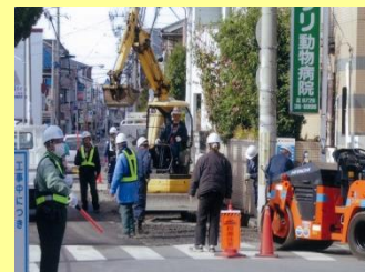
<道路改修作業>
