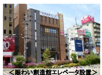
<賑わい創造館エレベータ設置>
