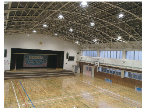
＜完成した屋内運動場非構造部材の耐震化＞
